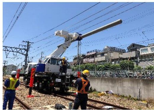
大型特殊車両作業
