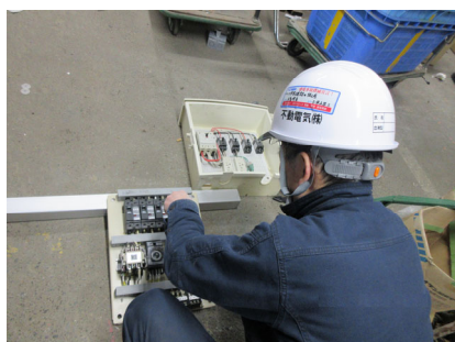
分電盤配線中
