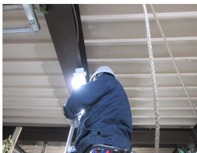
蛍光灯取替作業中
