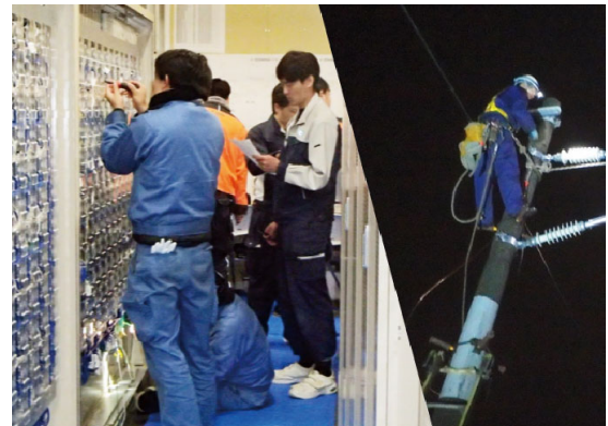
信号配線、電車線工事の様子
